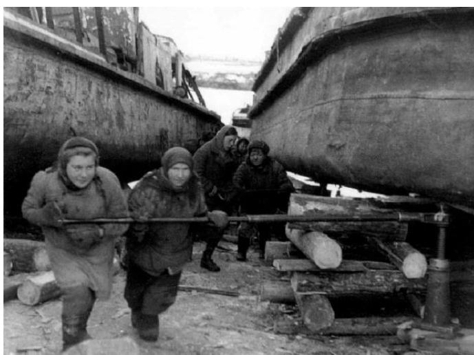
Рисунок 14 – Женщины поднимают на стапель катер для ремонта
